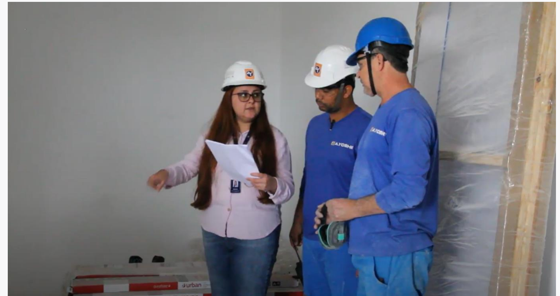
Figura 03: planejamento de curto prazo com líder de produção no canteiro de obras
